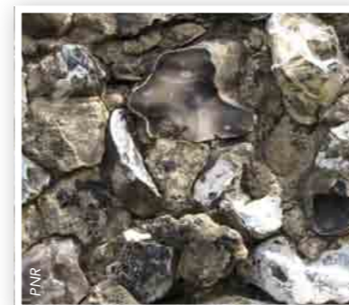
On trouve parfois dans les murets du littoral des « pierres de mer », qui étaient ramassées sur les plages et utilisées à proximité. Elles ont la particularité d'être saturées de sel marin et donc, dans certaines conditions d'humidité de l'air, de faire se condenser l'eau à leur surface. À Escalles, à l'extrémité du plateau crayeux, ce sont les silex qui ont servi à bâtir les murs. À noter aussi les pierres de type grès ferrugineux brun foncé presque noirs qui forment les murets au sud de Boulogne-sur-mer.
