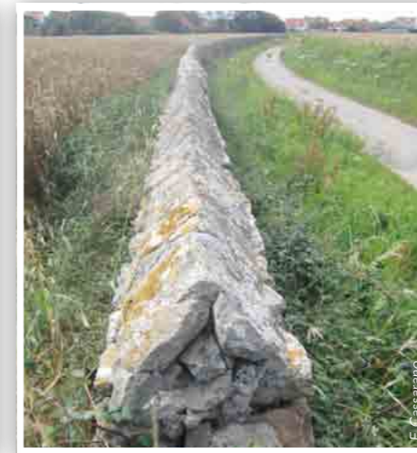
Chapeau composé de deux versants, maçonnés
