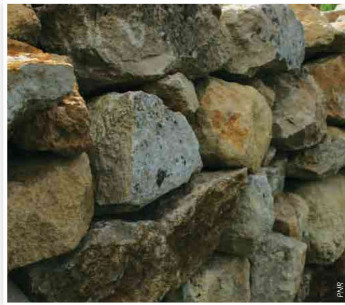
Détail d'un mur monté à sec, Colembert.
