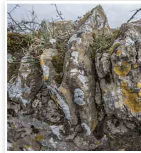
Chapeau en épi : les pierres sont posées à chant, à la verticale
